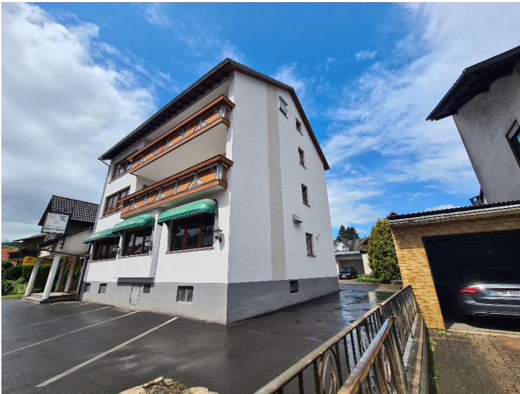
Gasthaus Grüner Baum 3 Geschosse und Sockelgeschoss.
